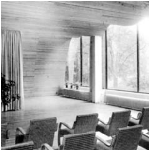
Le plafond acoustique de l'auditorium de la bibliothèque de Viipuri (1927-1934).
